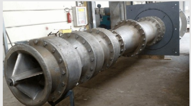
Revisione pompa raffreddamento centrale elettrica
